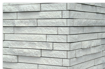
GRF10/S 準 出隅用カットユニット施工例
