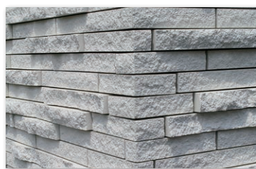
GRF10K/S 準 出隅用カットユニット施工例
